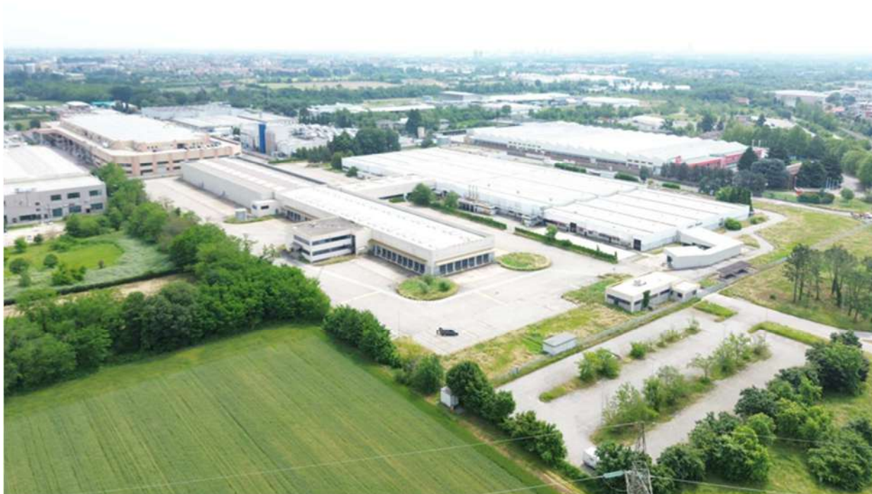
Fig. 31 – Foto aerea dello stato di fatto dell’area ex Gefco e Citroen
