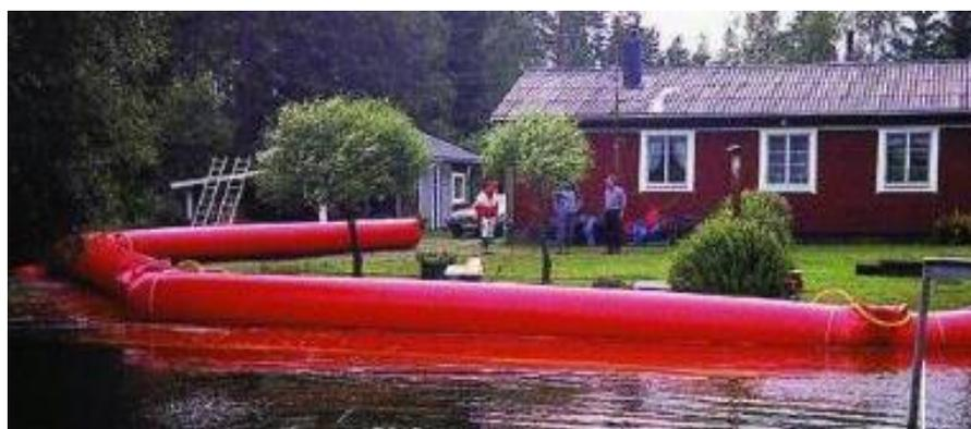
Figura 88 - Barriera temporanea antiesondazione riempita ad aria
