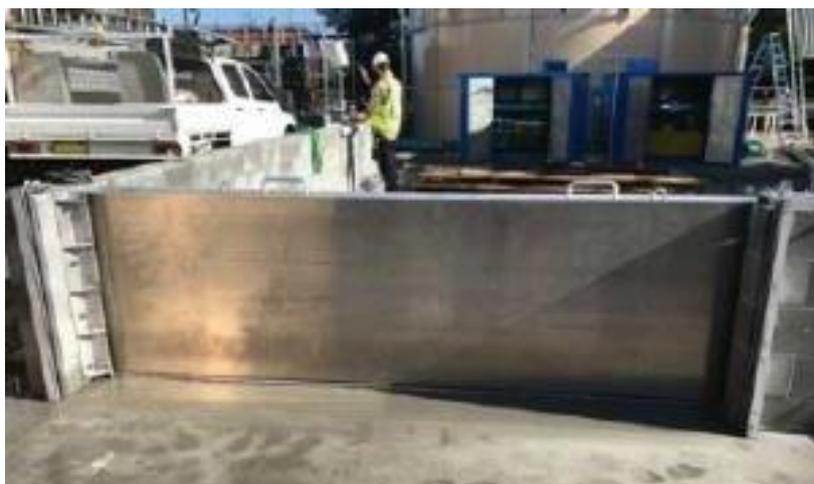
Figura 92 - Paratoia di chiusura a scorrimento orizzontale per un cancello a tenuta idraulica
