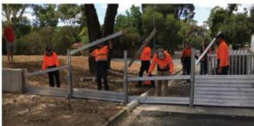
Figura 91 - Barriera temporanea modulare con pilastri e panconi manuali in alluminio
