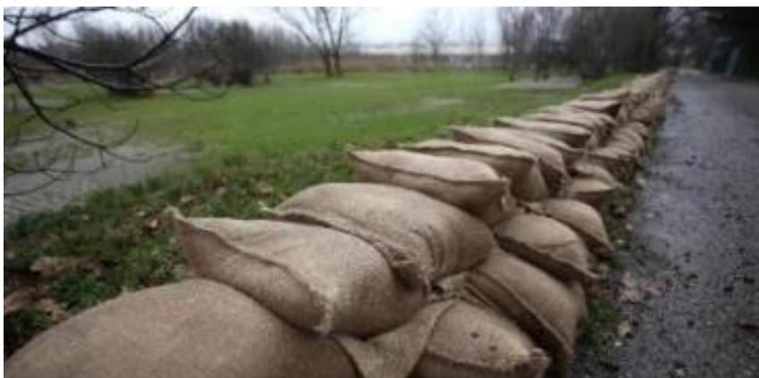
Figura 86 - Barriera temporanea antiesondazione in sacchi di sabbia
