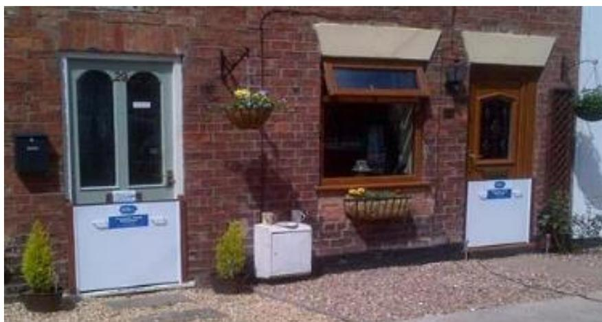
Figura 93 - Paratoie manuali a protezione di porte di ingresso
