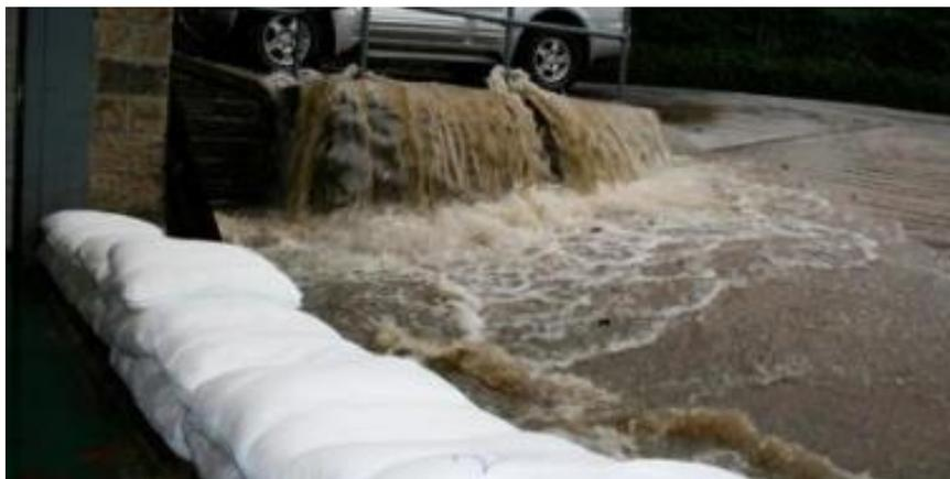
Figura 87 - Barriera temporanea in sacchi riempiti con materiale sintetico assorbente
