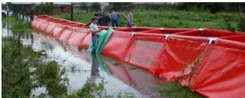
Figura 89 - Barriera temporanea antiesondazione riempita ad acqua
