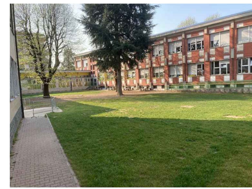
vista dell'area B di cantiere (cortile interno).
