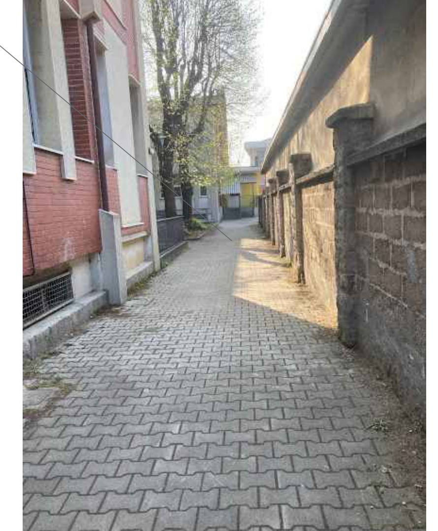
Corridoio di passaggio esterno accanto alla centrale termica
