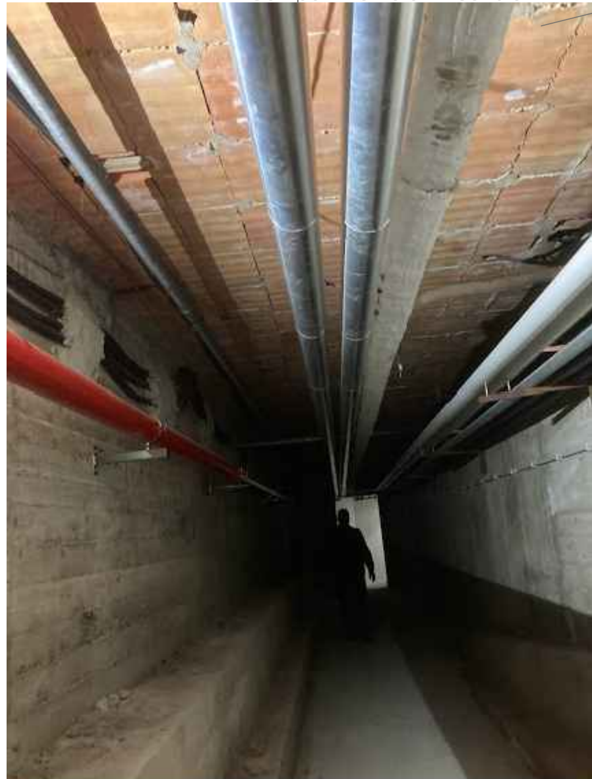
Compartimento antincendio n° 2
