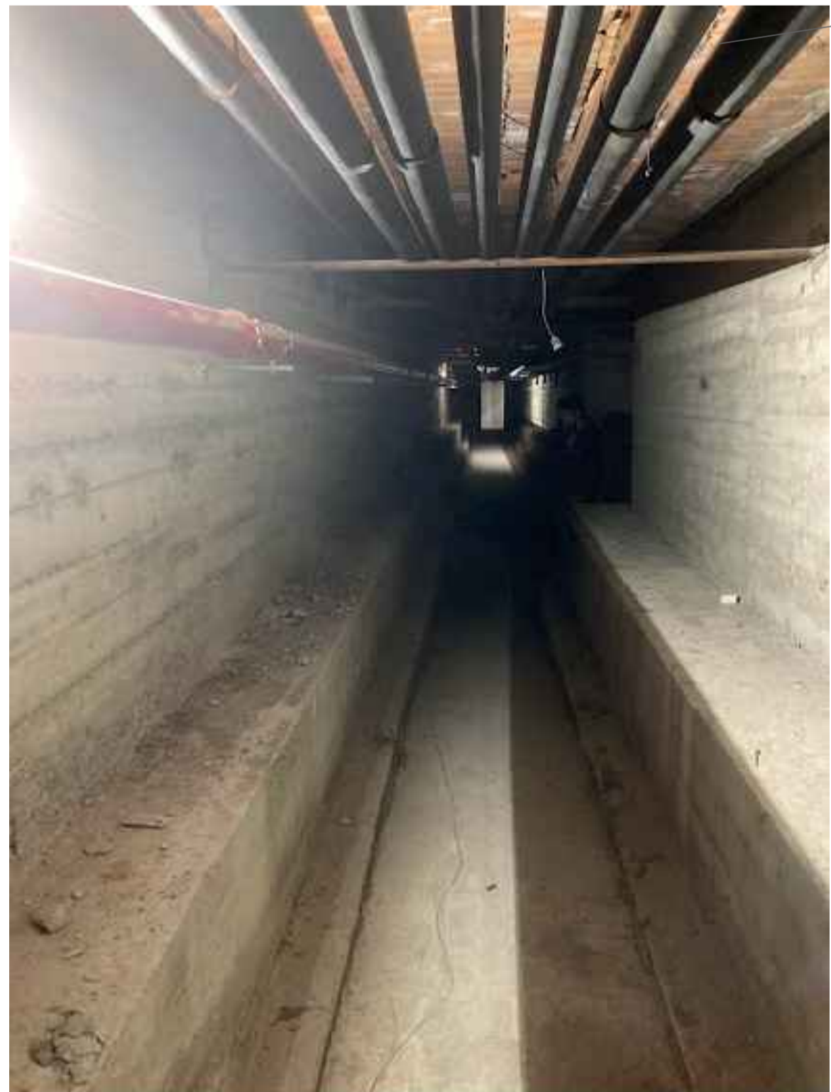
Compartimento antincendio n° 1
