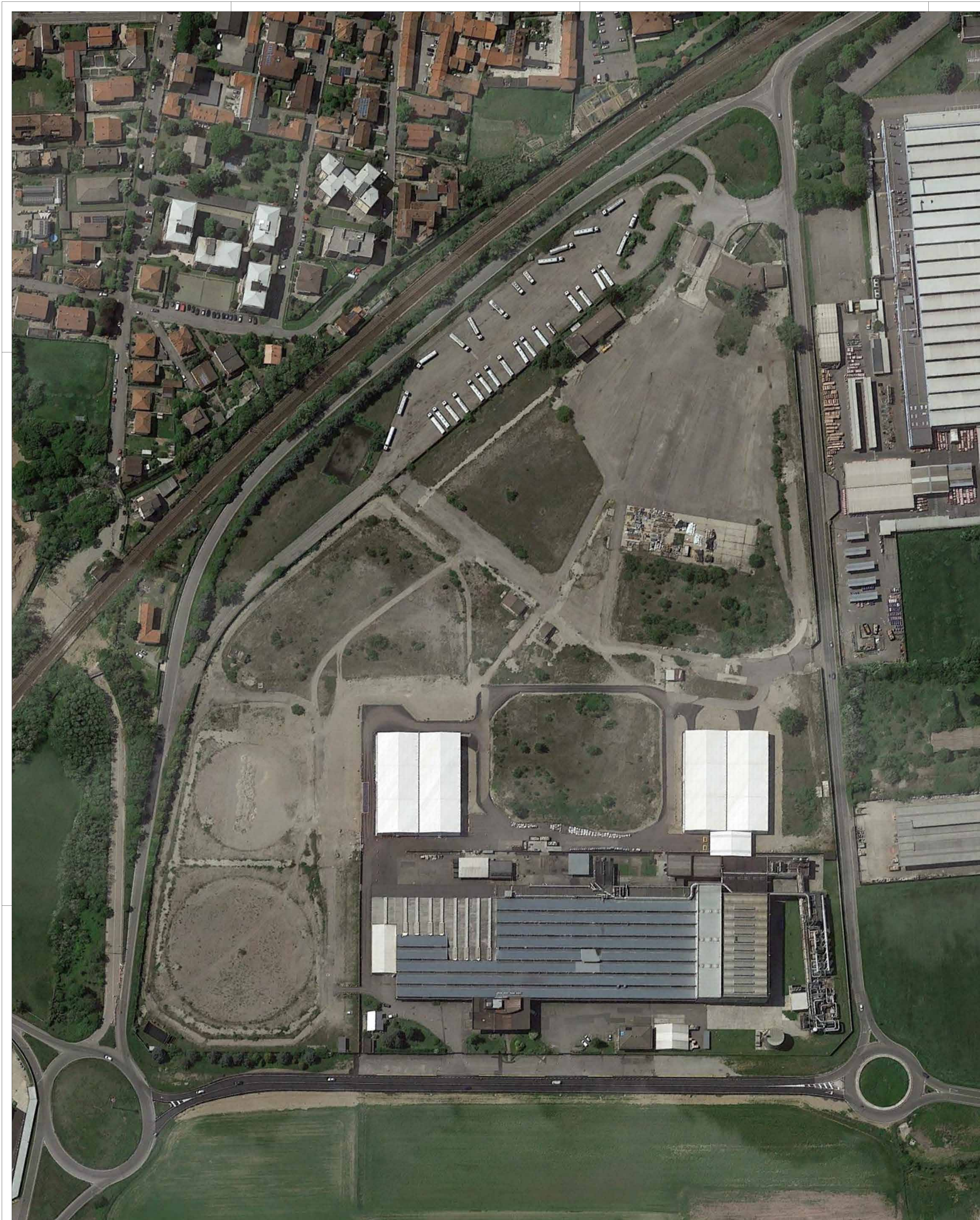
ORTOFOTO STATO DI FATTO
