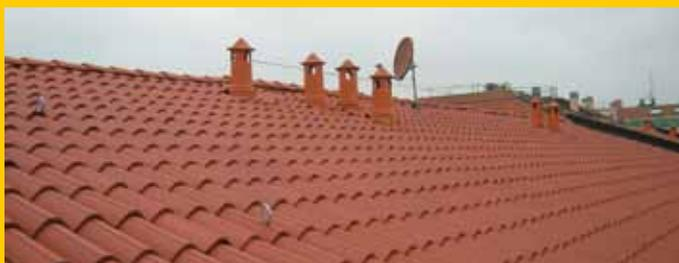
E' stato eseguito il rifacimento del tetto del lotto "B", con la integrale sostituzione del manto di tegole e la realizzazione della "linea vita" che consentirà che i futuri interventi di manutenzione saranno eseguiti in sicurezza senza l'ausilio di autoscafe o ponteggi. L'investimento è stato di circa 40.000,00 euro.
